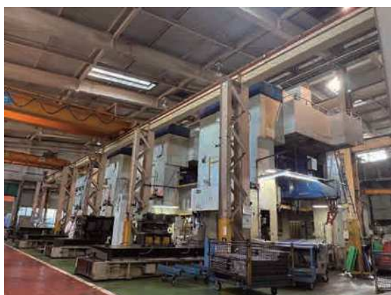
全自动TDN冲压流水线 600t，400t×3台
